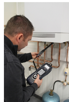
Vérification CO ambiant
